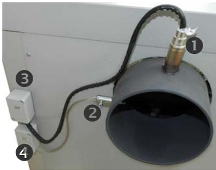
La limpieza de la sonda lambda y el sensor de gases es importante para el correcto funcionamiento. Utilice una toallita húmeda para limpiar con cuidado la sonda lambda „1“ sensor de gases „2“
