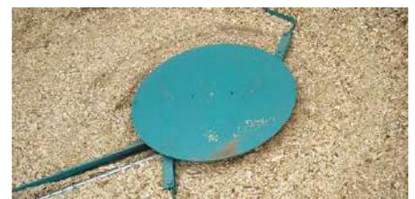
El novedoso sistema de recogida de combustible del silo hizo posible **quemar astilla de forma totalmente automática**.
