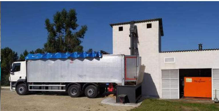
Instalación de caldera Heizomat de 150 kW y silo para astilla con capacidad para 17 m<sup>3</sup>. El llenado del silo se realiza, de forma rápida y cómoda mediante un cargador, que introduce el combustible en el silo de forma automática. El calor generado se utiliza para una granja porcina, que necesita calor las 24 horas del día, los 365 días al año. Ubicada en San Martiño de Vilar – Pontevedra.
